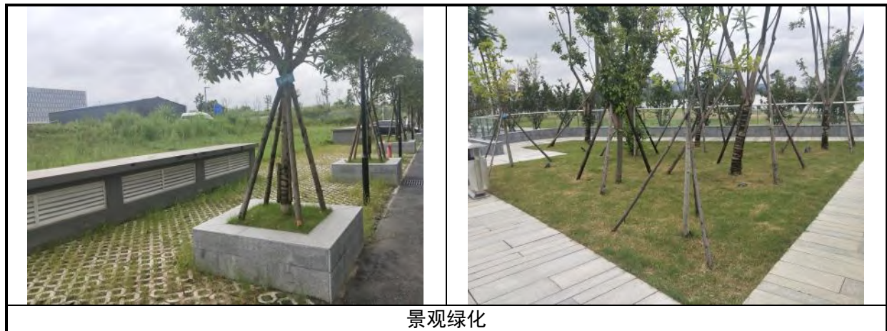
图 3-2 地上建筑区水土保持措施现状图
