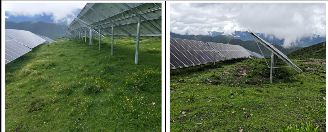
光伏片区 1 绿化（2019.7）
