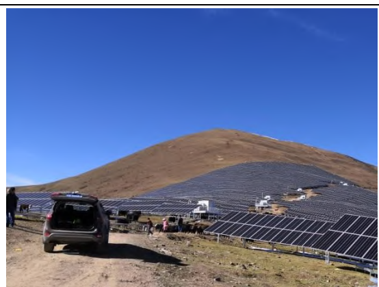
道路工程现状 (2019.11)
