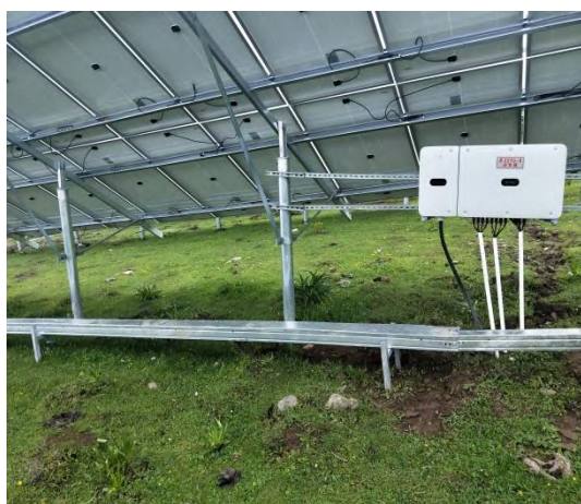
图 1-4 场内集电线路
