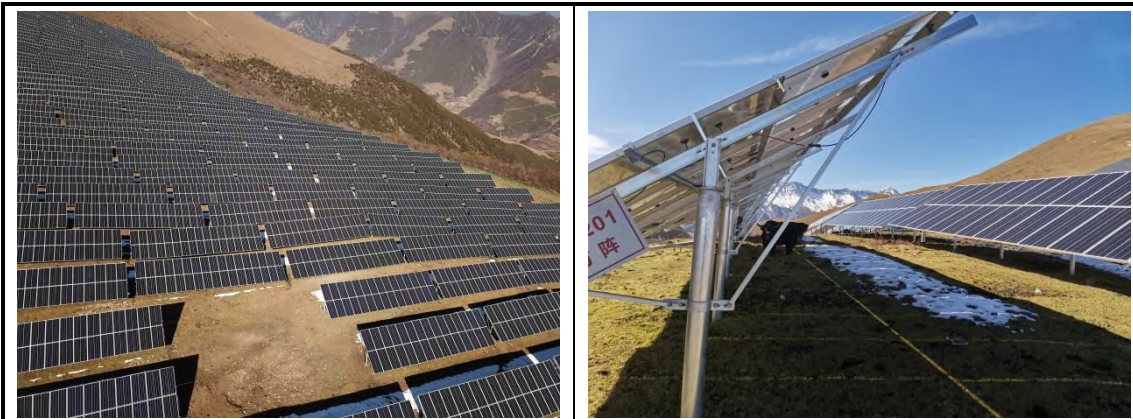
光伏阵列区现状 (2019.11)
