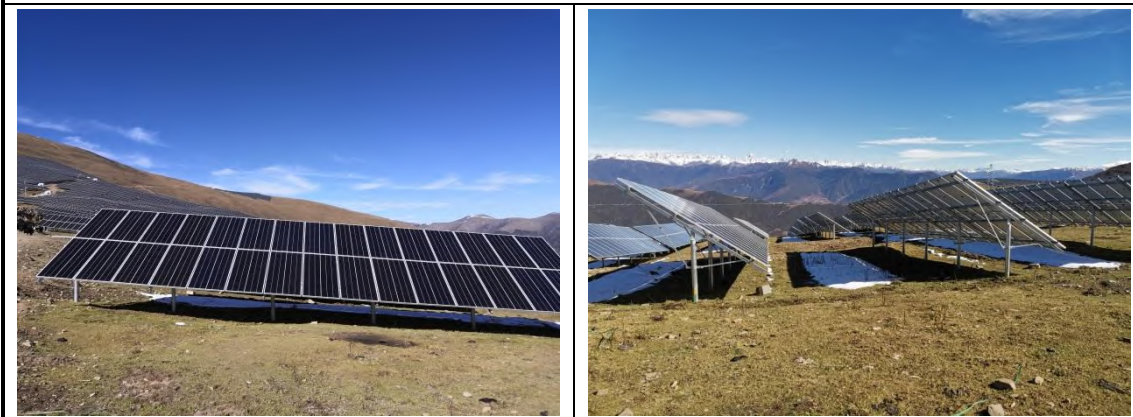
光伏阵列区现状 (2019.11)
